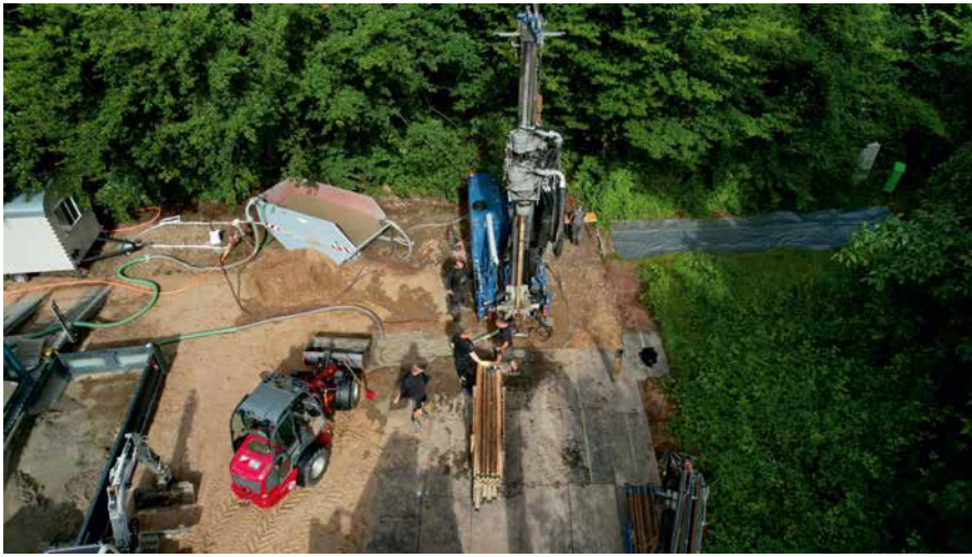
Abb. 3: Testbohrung für den sog. Thermal Response Test zur Dimensionierung eines Erdwärmesondenfeldes Quelle: VBK
